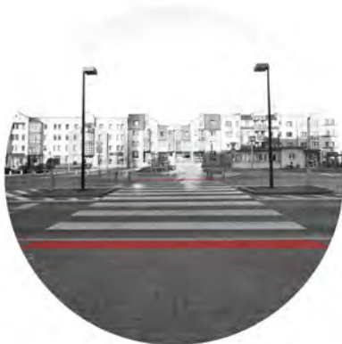
Fot. 1.2. Przejścia dla pieszych prowadzące na Plac Wolności są niedostosowane do potrzeb osób niewidomych.
