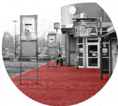
Fot. 1.1. Nawierzchnia przystanków wykonana jest z kostki brukowej o wysokiej nieregularności.
